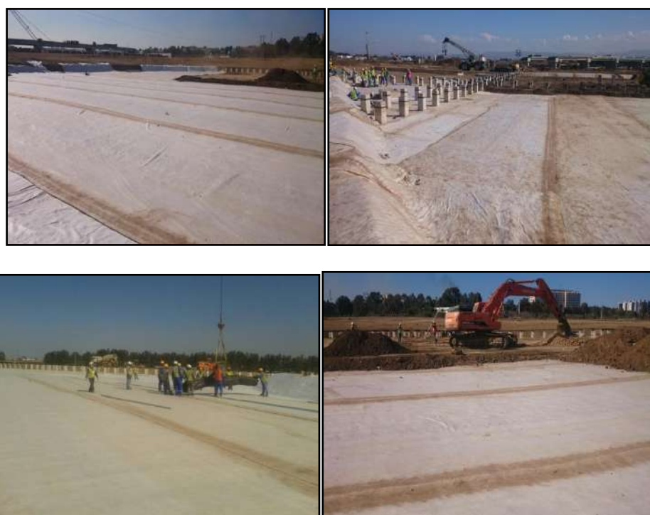
Figure 8. Photos de mise en place du GSB
