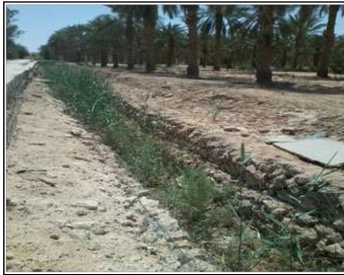
Photo 1. Etat du réseau de drainage à l'exploitation
