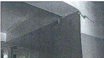
Figure 6. Fissures horizontales en têtes des cloisons intérieures
