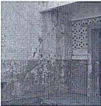
Figure12. Fissures en croix à sur un pignon à l'entrée du bâtiment
