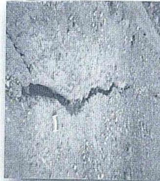
b) Fissure de la chaussée côté aval
