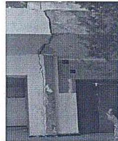
Figure15. Ouverture du joint
